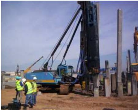
Somos los primeros consultores independientes de España en realizar ensayos dinámicos de **pilotes prefabricados hincados** con equipos propios, utilizando software Capwap para la interpretación de los resultados.
