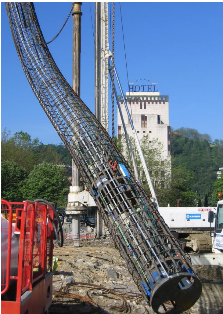
Figura 28. Armadura de pilote con dos células Osterberg (RK)
