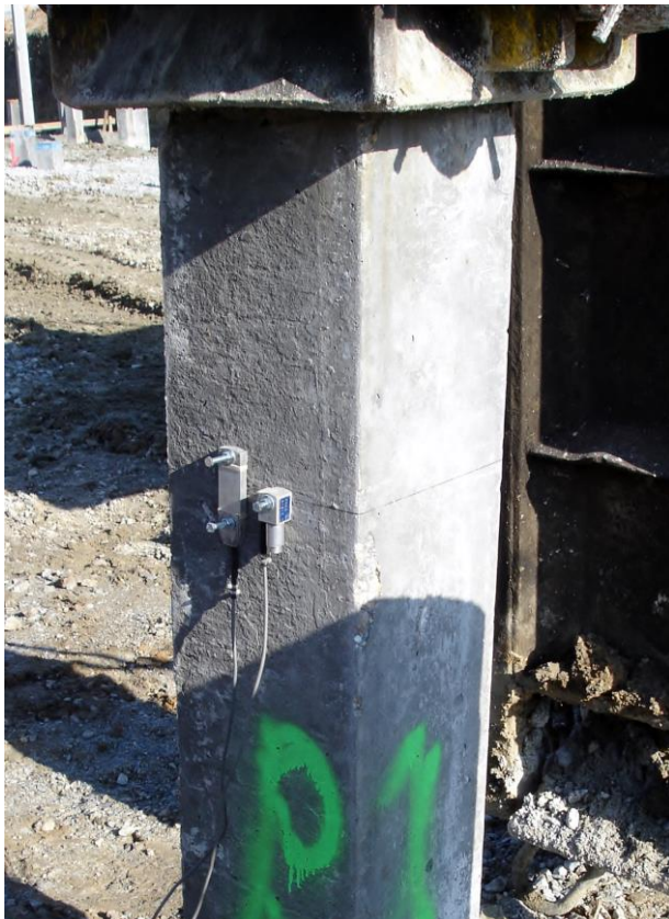
Figura 14. Sensores sobre el pilote durante la prueba (RK)
