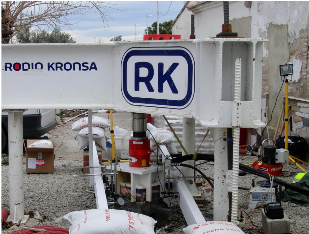
Figura 7. Montaje general de la prueba para la caracterización termo-mecánica (RK)
