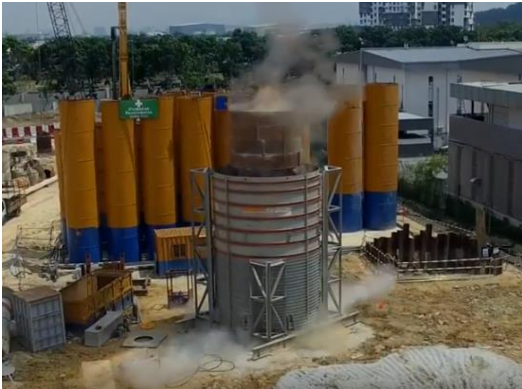
Figura 29. Lanzamiento de la masa hacia arriba como consecuencia de la ignición.
