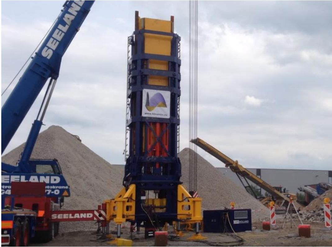
Figura 30. Lanzamiento de la masa por caída libre sobre el pilote.
