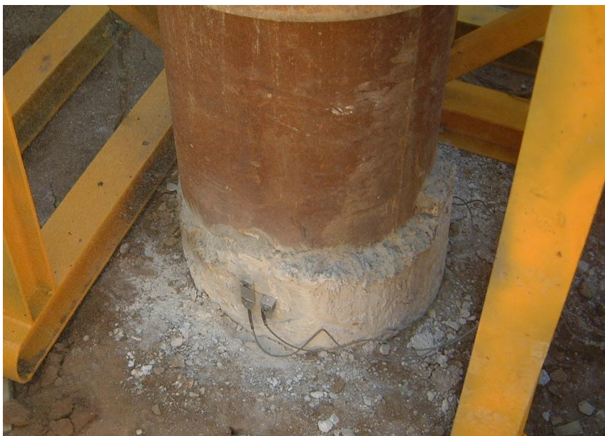
Figura 20. Pilote in situ instrumentado para ensayo dinámico (Terratest)
