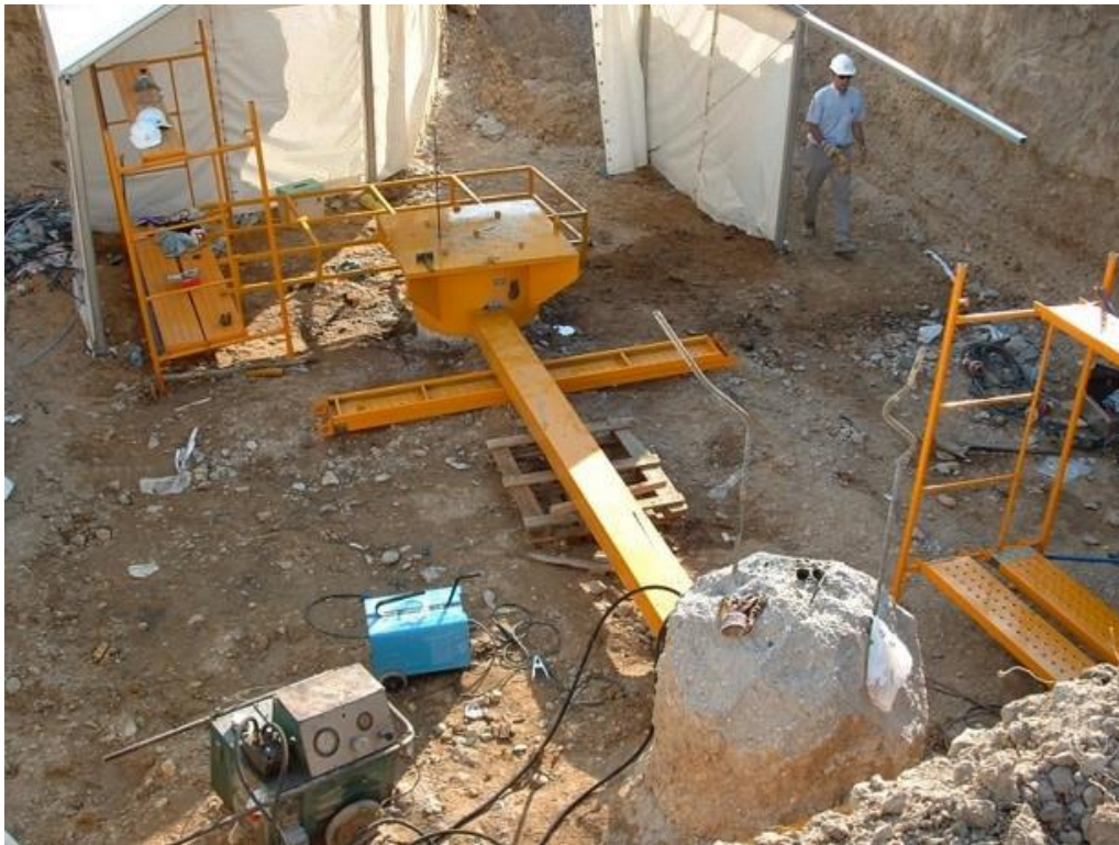
Figura 13. Prueba de carga lateral en pilotes in situ (Terratest)
