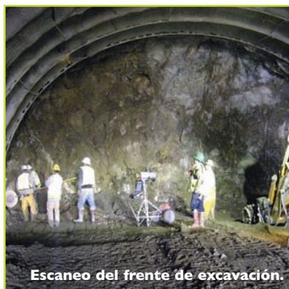
Escáner láser Dibit en el interior de un túnel en construcción
