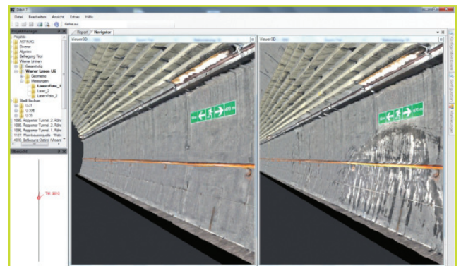
Evolución de daños: comparación entre dos inspecciones sucesivas.
