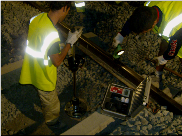
Figura 4: Ejecución del ensayo de carga con placa dinámica sobre el subbalasto en plataforma en servicio.
