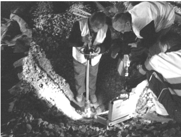
Figura 15. Ensayo de carga con placa dinámica realizado entre las dos vías.
