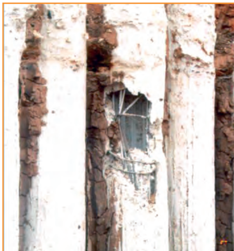
Los ensayos de integridad de pilotes permiten determinar fallos en los mismos.
